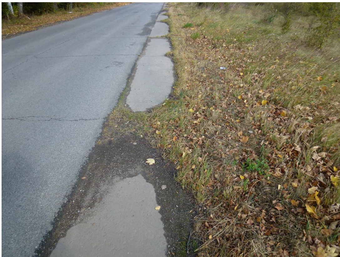
Fot. Z5. Widok uszkodzonej nawierzchni
