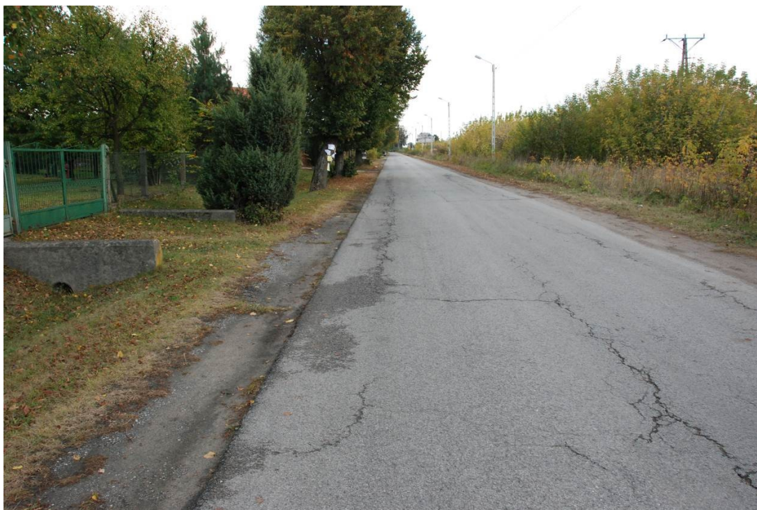
Fot. Z6. Widok uszkodzonej nawierzchni
