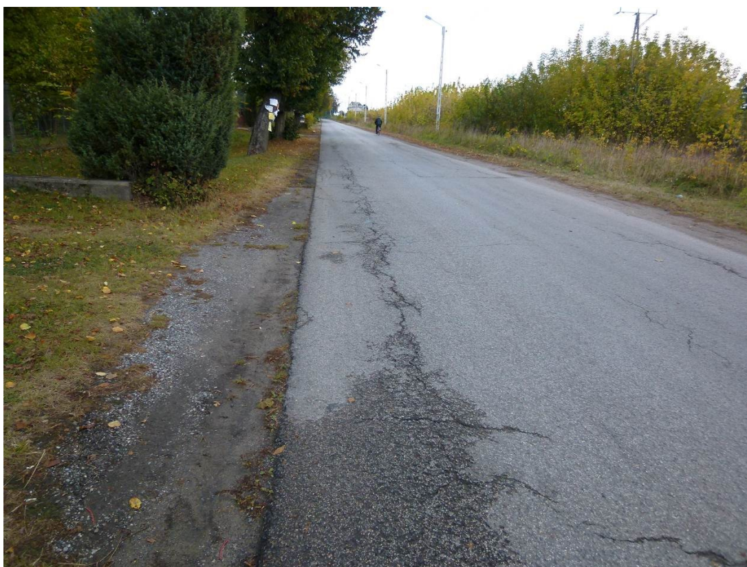
Fot Z2. Widok uszkodzonej nawierzchni
