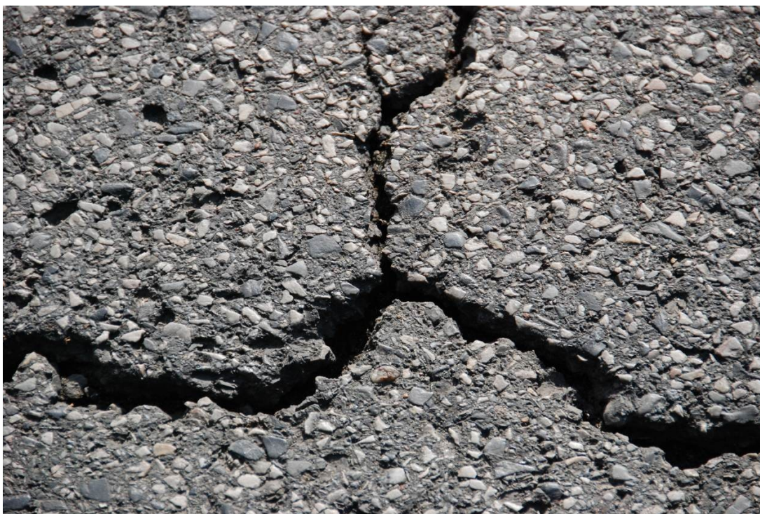
Fot. Z9. Widok uszkodzonej nawierzchni
