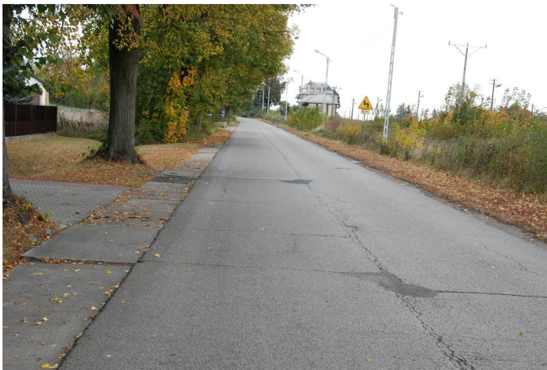
Fot. Z7. Widok uszkodzonej nawierzchni
